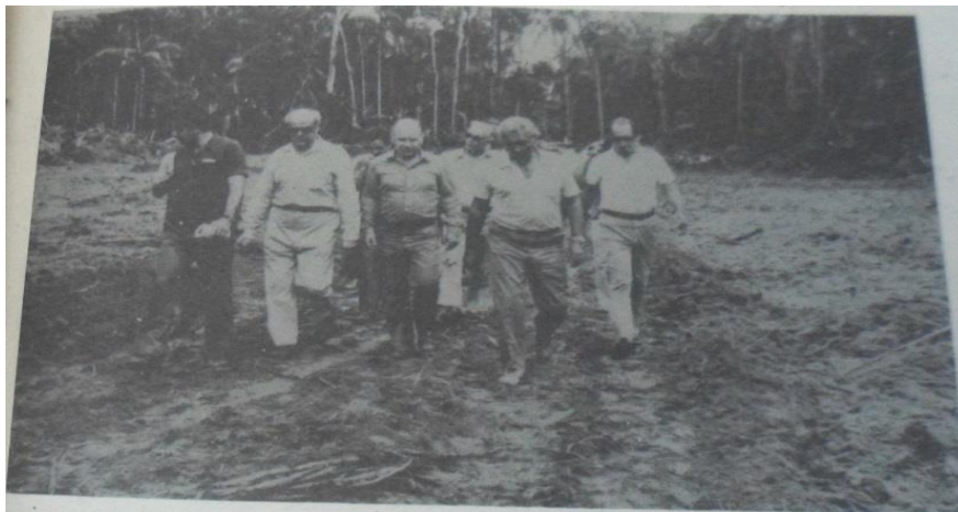
Figura 3: Visita a construção da Perimetral Norte. Fonte: Jornal Boa Vista
