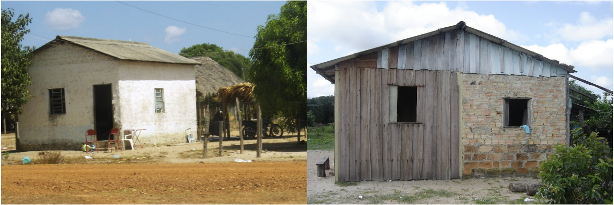
Figura 12 – Do lado esquerdo casa com cobertura de telha de amianto e ao fundo uma cobertura de palha de injá. Do lado direito, casa construída uma parte com tijolos e outra parte com tábuas da madeira marupá ( Simarouba amara ).
