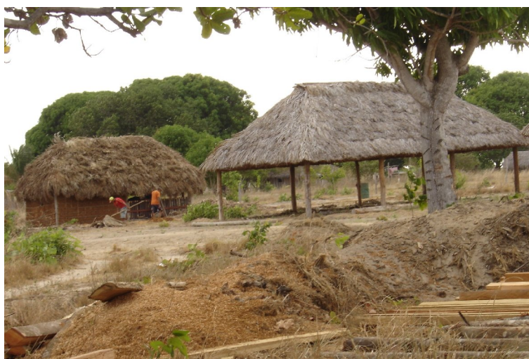
Figura 8 – Do lado esquerdo uma maloca coberta com palha de buriti ( Mauritia flexuosa ). Do lado direito um malocão coberto com palha de inajá ( Attalea maripa ).
