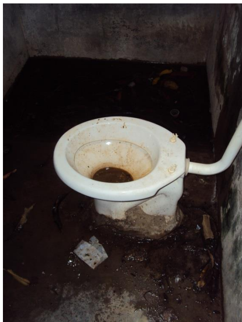
Fotografia 9 – Banheiro nas dependências da escola
