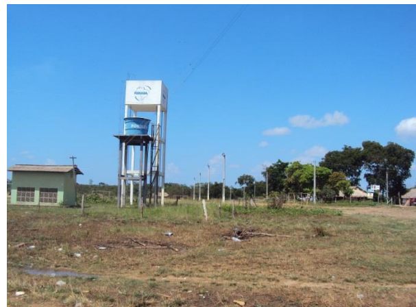
Fotografia 20 – Poço perfurado da FUNASA
