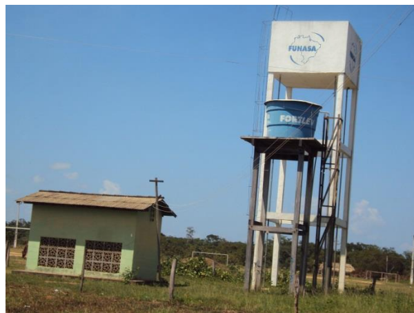
Fotografia 4 – Fornecimento de água encanada e energia elétrica
