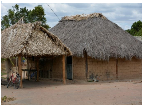
Fotografia 3 – Habitação construída com adobe e palha
