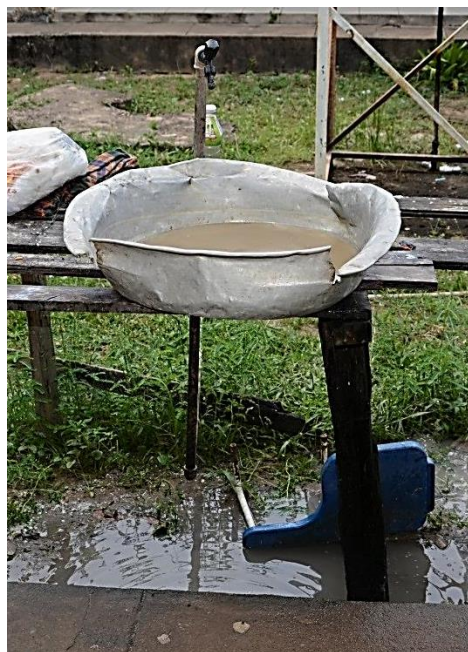
Fotografia 12 – Ausência de rede de escoamento de água
