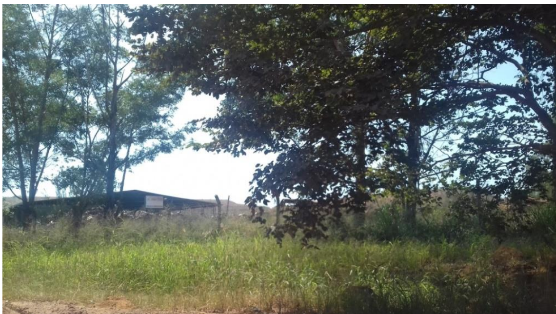
Figura 12 - Galpão da Cooperativa Unirenda que encontra-se dentro do terreno do aterro.
