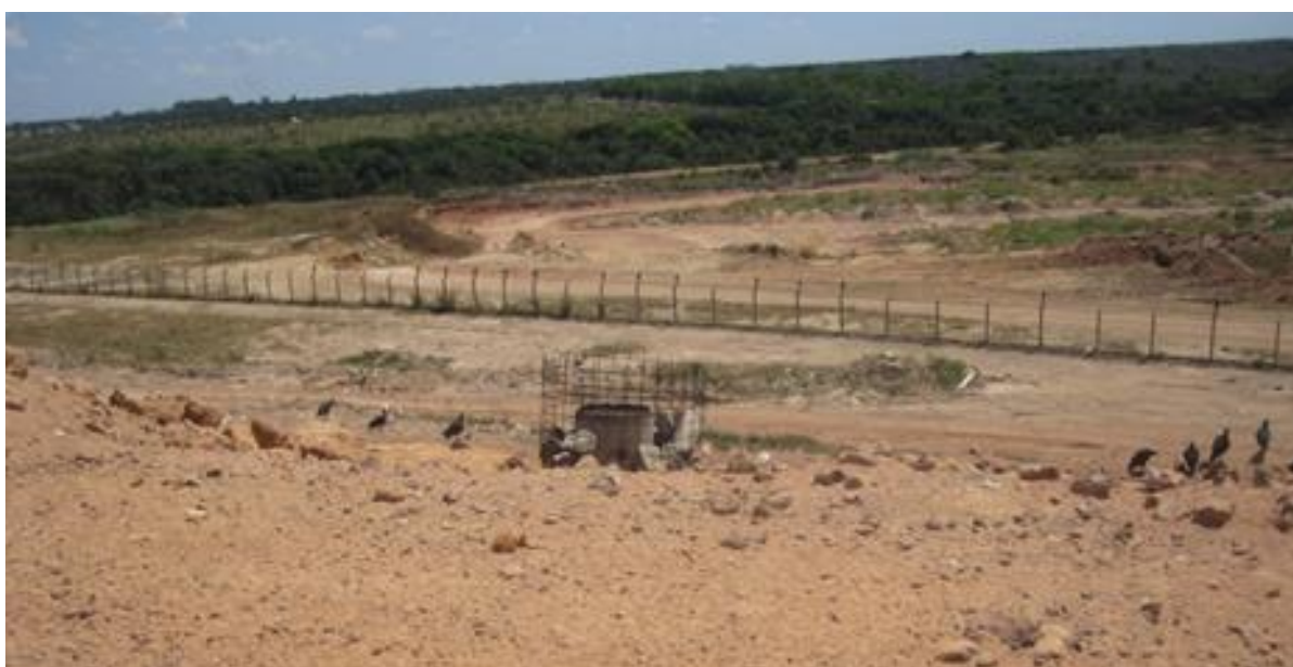
Figura 11 - Vista do Aterro Sanitário Municipal de Boa Vista/Roraima em outubro/2018, com o Dreno onde é realizada a queima dos gases ao centro.
