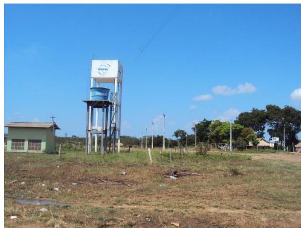
Fotografia 20 – Poço perfurado da FUNASA
