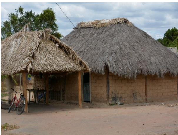
Fotografia 3 – Habitação construída com adobe e palha
