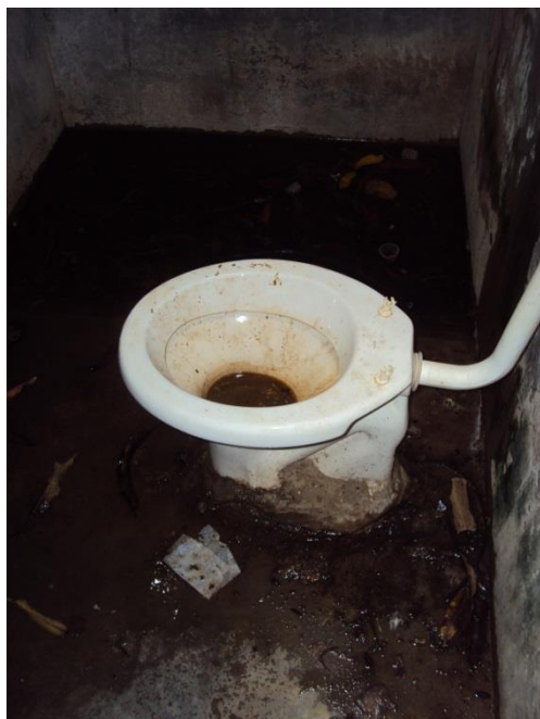
Fotografia 9 – Banheiro nas dependências da escola
