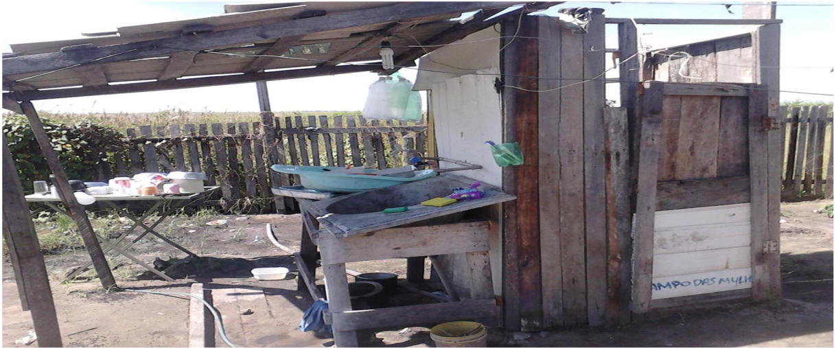
Fotografia 2 . Banheiro/Cozinha improvisados em domicílio (Conjunto Cidadão)
