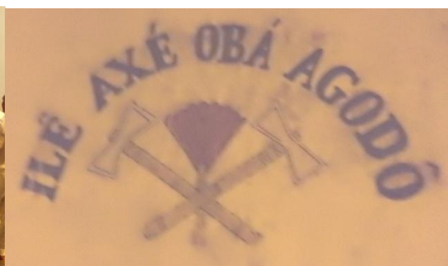
FOTOGRAFIA 04. Pintura abrasão no muro externo do local. (16.01.2013)
