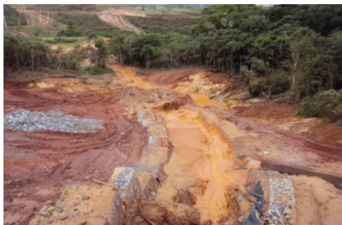
Foto 7: Caminho do mineroduto.
