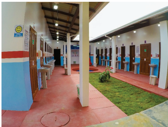
Figura 3: Construção das Instalações Concluída
