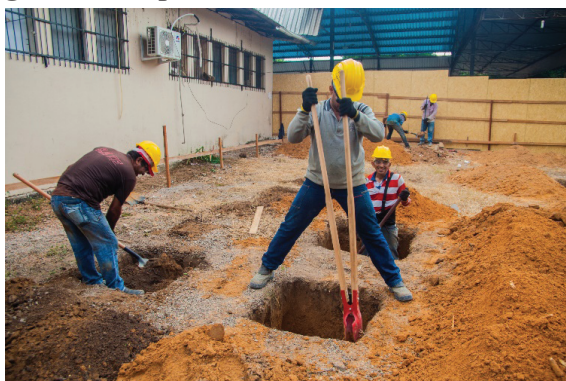
Figura 2: Etapa de Construção das Instalações
