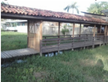
Figura 2: Casa 01 em área de ponte
