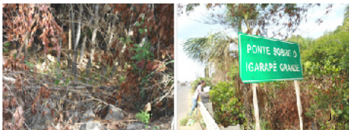
Figura 5 - Queimada na margem do igarapé (I); Ponte sobre o Igarapé Grande BR 174 (J)
