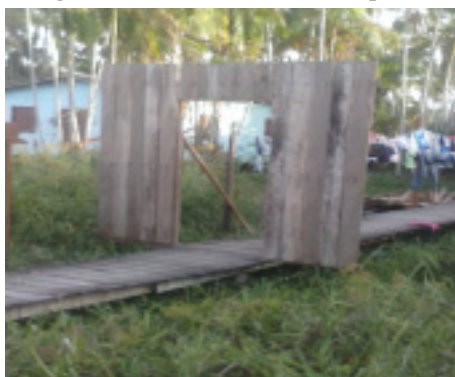
Figura 4: Casa 03 em área de ponte
