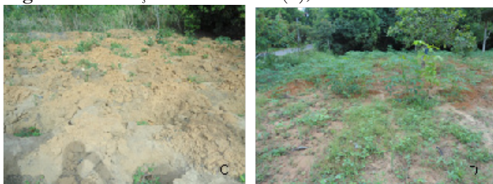
Figura 2 - Remoção da mata ciliar (C); Erosão e assoreamento (D)
