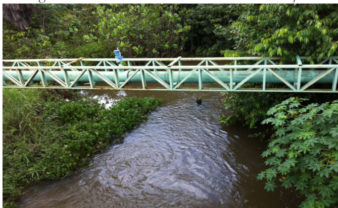
Figura 2 - Ponto 2 – BR 174 - Ponte estabilização
