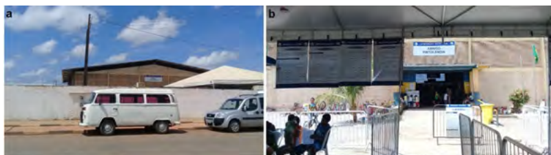
Figura 2: Abrigo Pintolândia: abrigo indígena em Boa Vista: (a) fachada externa; (b) área interna.
