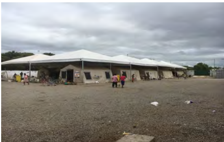
Figura 01: Cabanas ao lado do ginásio presentes no abrigo.
