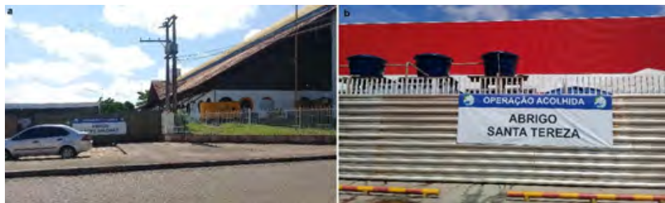
Figura 6: Abrigos temporários: (a) Abrigo Latife Salomão; (b) Abrigo Santa Tereza.
