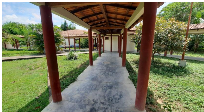
Corredores entre os 4 blocos do Instituto Insikiran, 2023.
