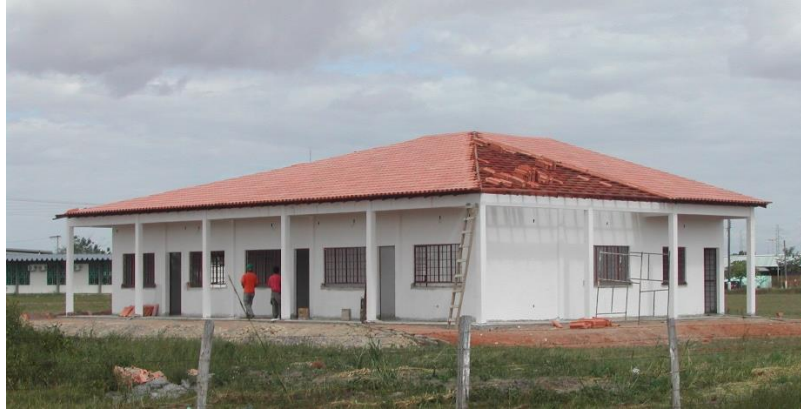
Primeiras obras na construção do Instituto Insikiran, 2006.
