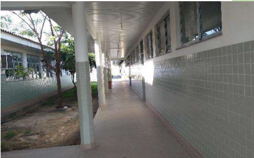
Uma das ruas da escola, que dá acesso às salas provisórias e ao ginásio
