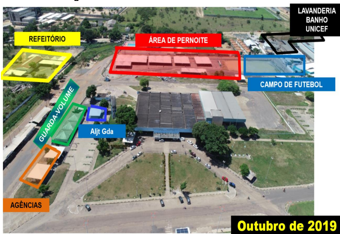
Figura 4: PRA- Rodoviária Internacional de Boa Vista.
