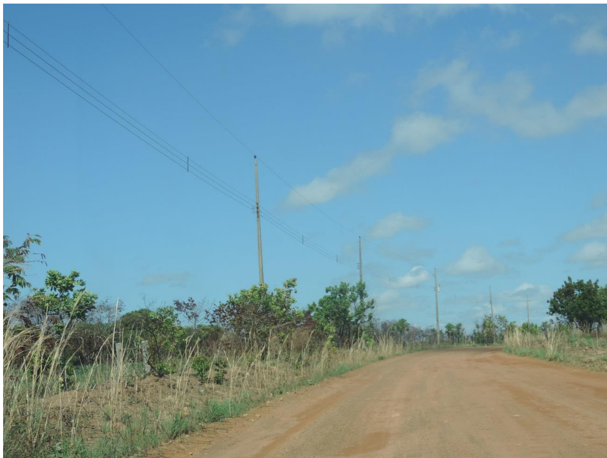
FIGURA 5 – Vicinal de entrada ao Assentamento via EAGRO/UFRR
