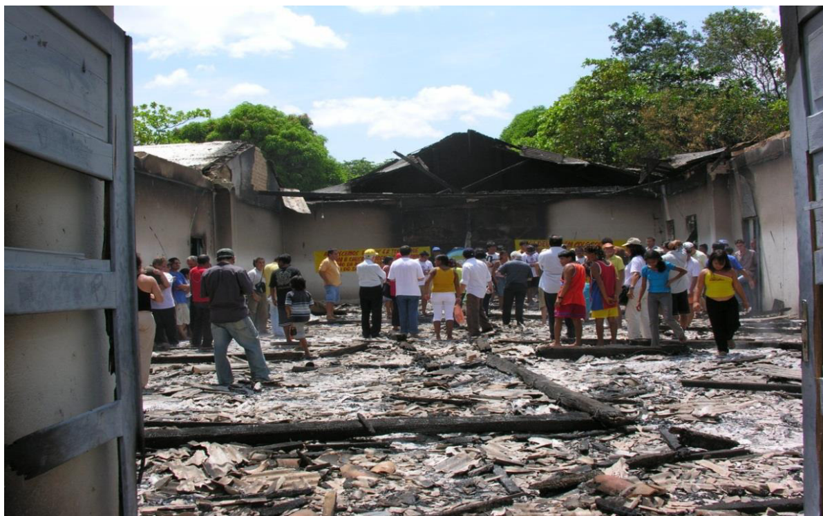
Figura 5: Destruição das instalações do Centro de Formação Indígena Fonte: Arquivo da Diocese de Roraima (2005)
