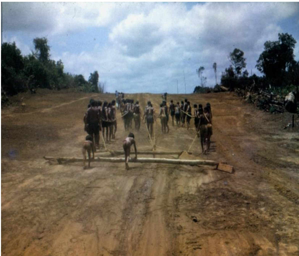
Figura 9 – Construção da pista de pouso em Kanaxen
