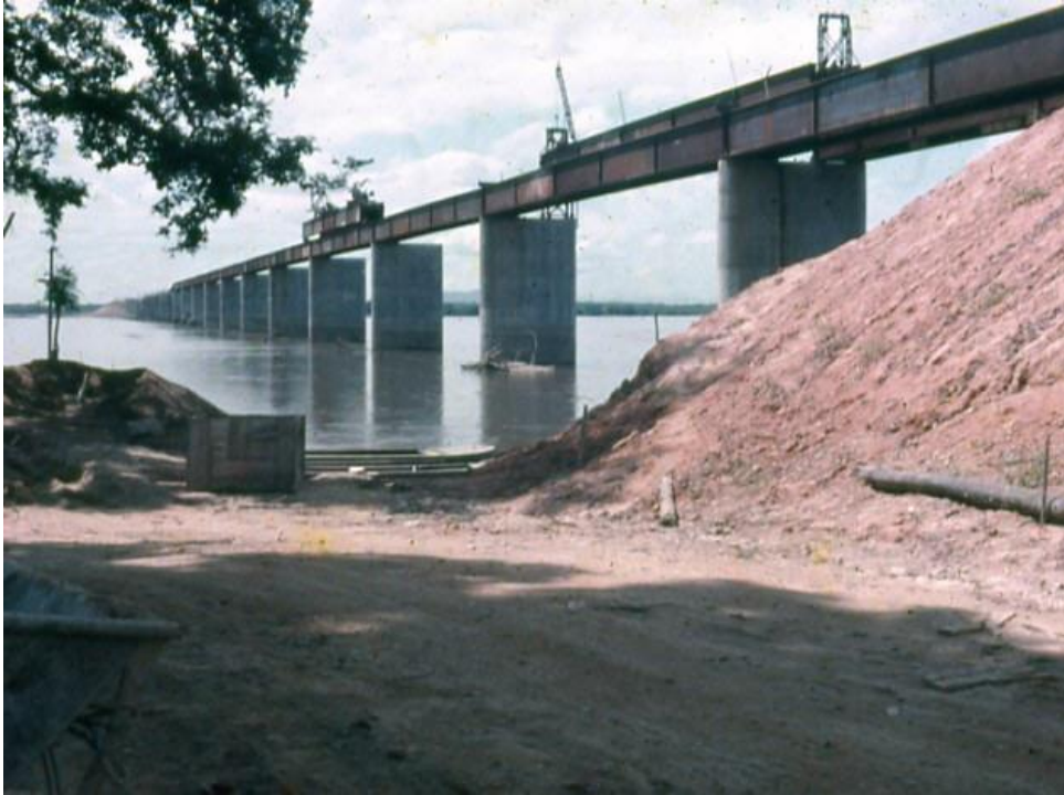
Figura 22 – Construção da Ponte dos Macuxis – 1975.
