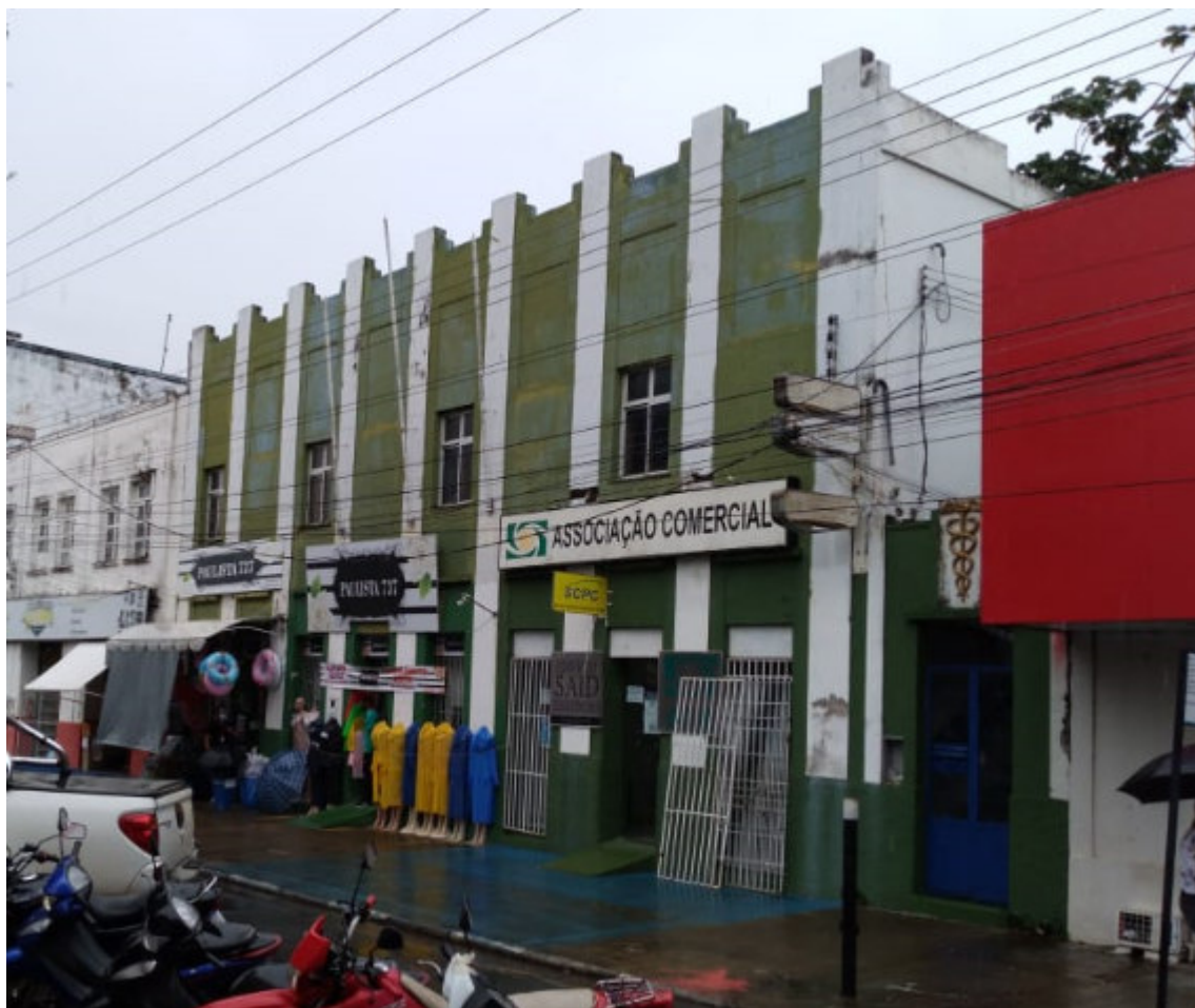
Figura 46: Prédio onde funcionou o jornal O Átomo
