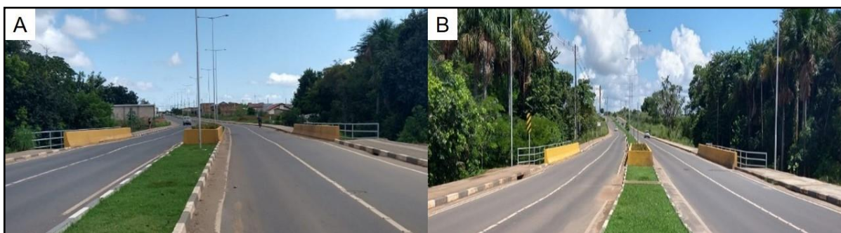
Figura 32 - Pontes de concreto das novas vias de acesso no bairro Cidade Satélite
