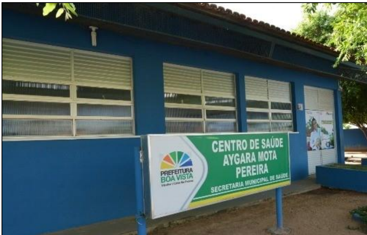
Figura 41 - Reforma da Unidade Básica de Saúde (UBS) Aygara Mota Pereira
