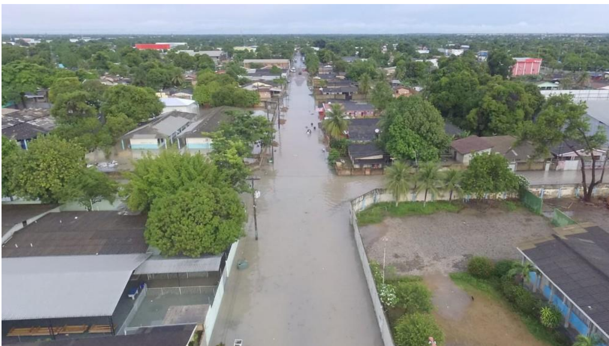
Figura 10 - Rua Leôncio Barbosa, alagada, no bairro Tancredo Neves na Zona Oeste de Boa Vista em 06/07/2020
