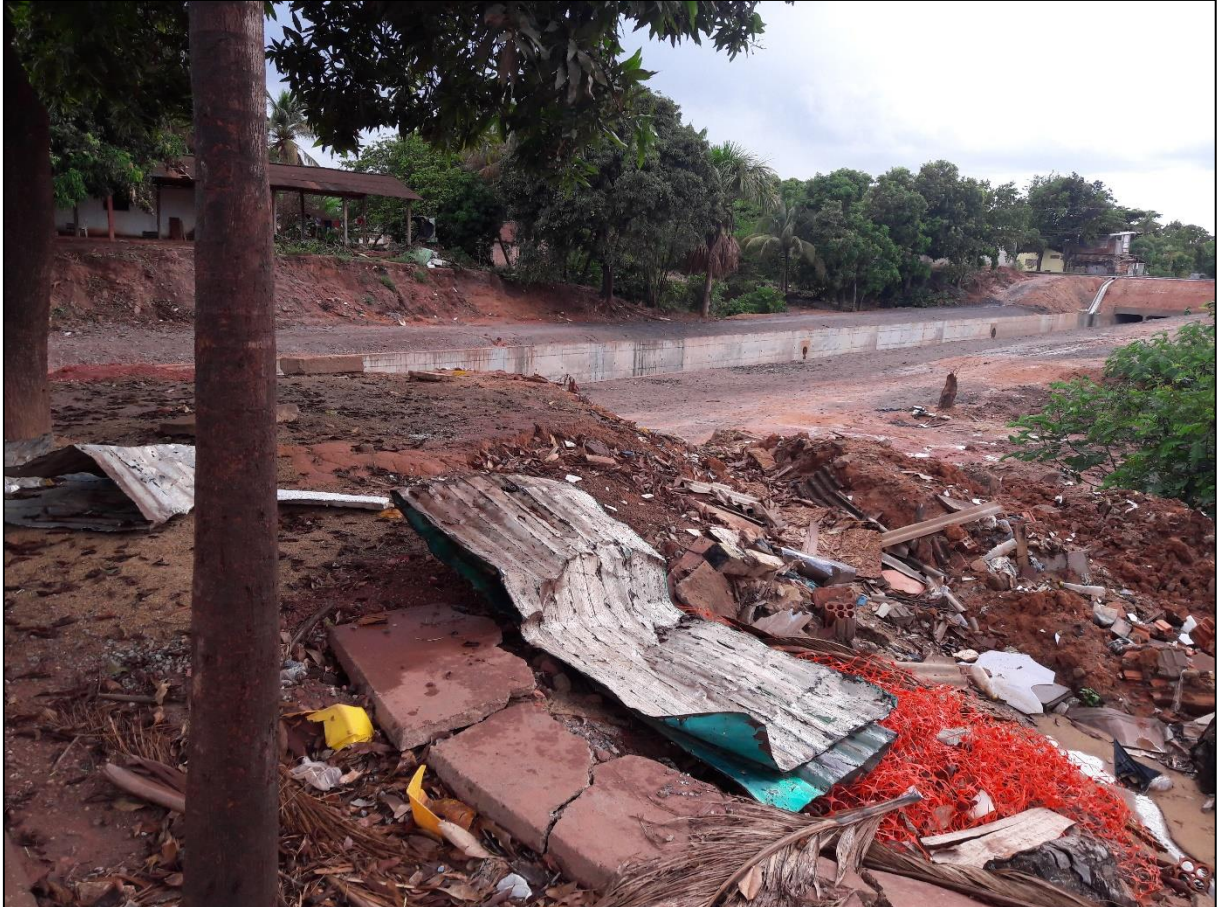
Figura 18 – Obras de macrodrenagem do Igarapé Caxangá
