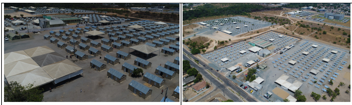
Figura 47 - Construção de abrigos e bases utilizadas pela Força-Tarefa (Pacaraima 2019)
