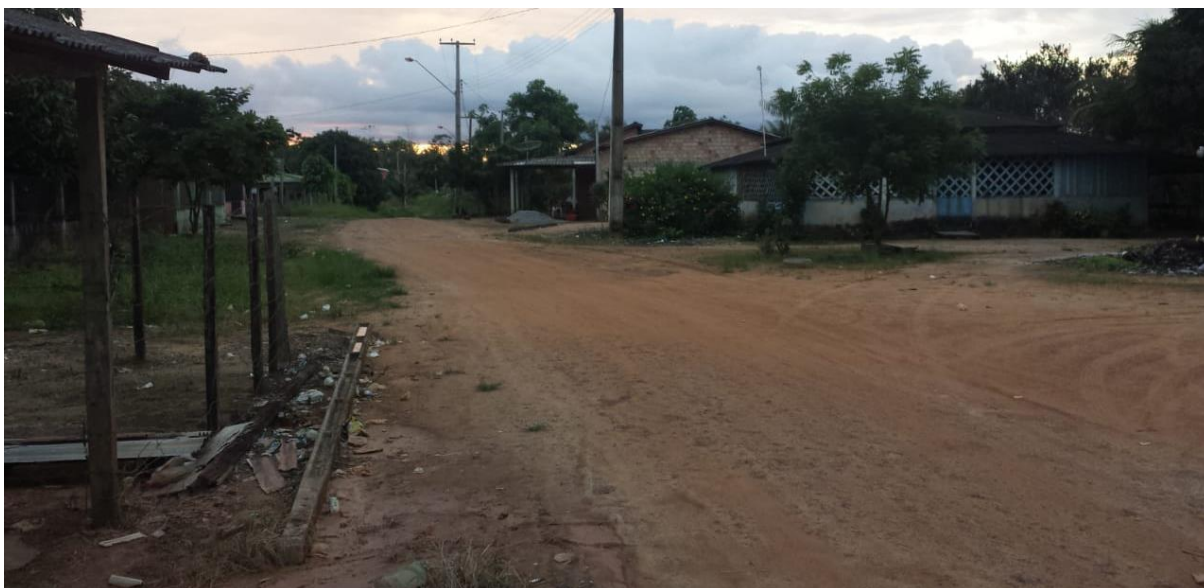
Figura 7 - Vias não asfaltadas na Vila da Penha
