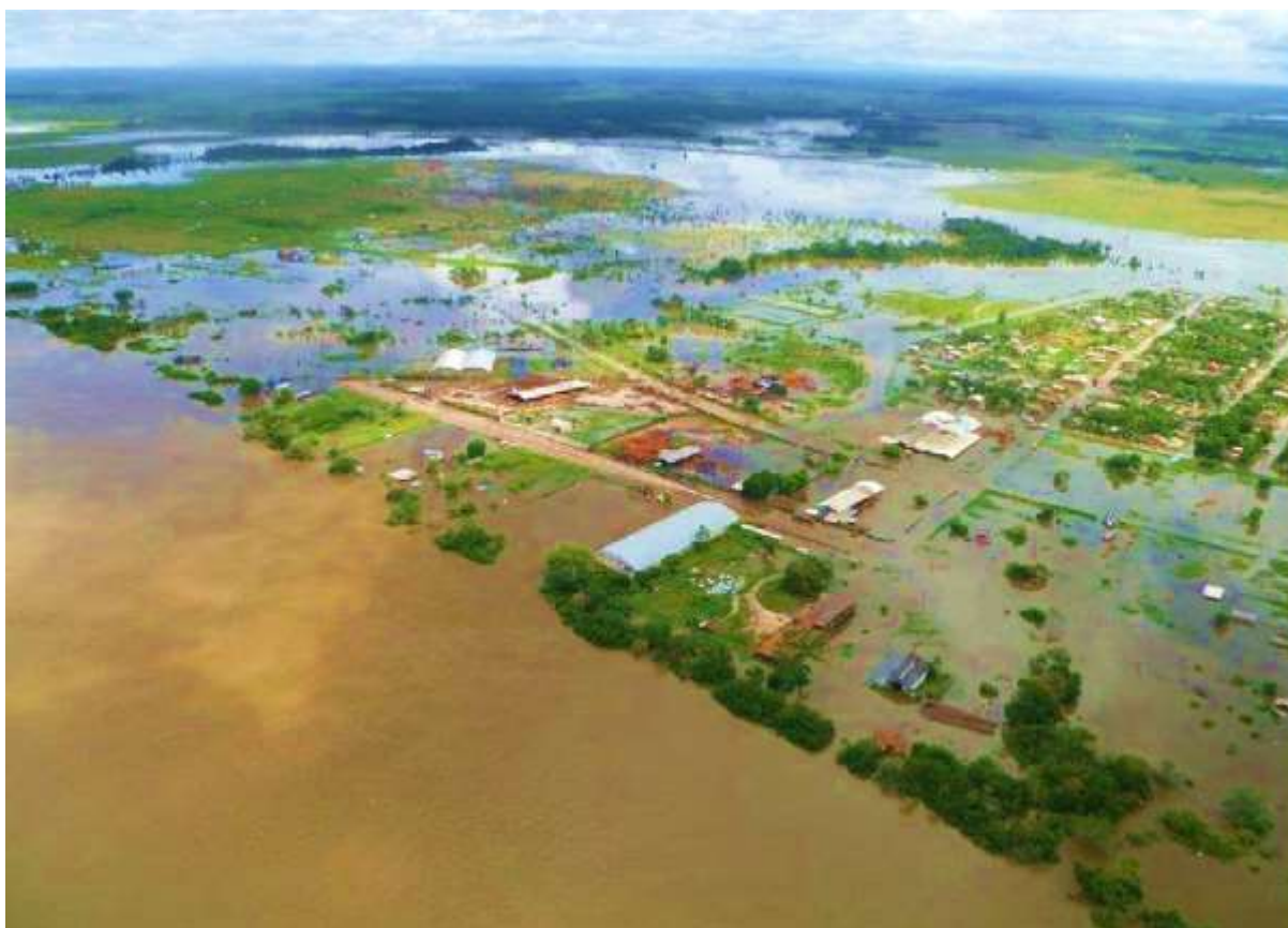
Figura 64 - Sede Municipal de Caracaraí – RR inundada em 2011.
