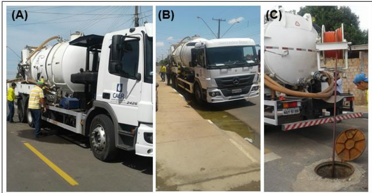
Figura 40 – Procedimento para desobstrução de PV em via pública (A) Análise do local pela equipe de campo (B) retirada de equipamentos (C) Introdução de equipamento no PV.
