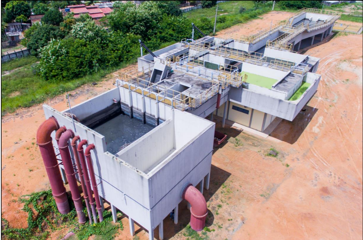
Figura 36 – Unidade de pré-tratamento que antecede o tratamento nas lagoas de estabilização.
