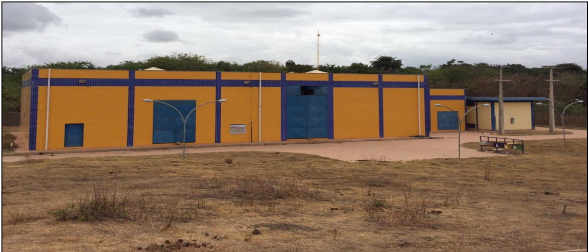
Figura 35 – Estação Elevatória de Esgoto Igarapé Grande, situada no bairro Aracelis S. Maior.
