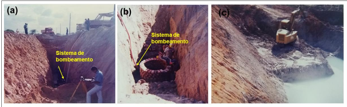
Figura 42 – (a) Controle topográfico na implantação do coletor-tronco Caxangá (b) Execução de PV em alvenaria (c) Escavação no solo para implantação da estação elevatória de esgoto Caxangá.
