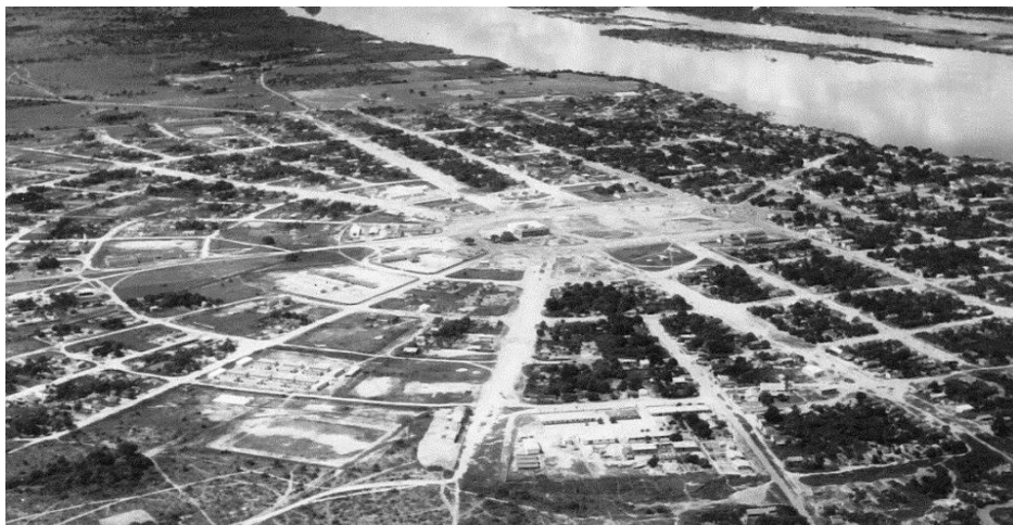
Figura 4- Imagem do traçado concêntrico da cidade de Boa Vista
