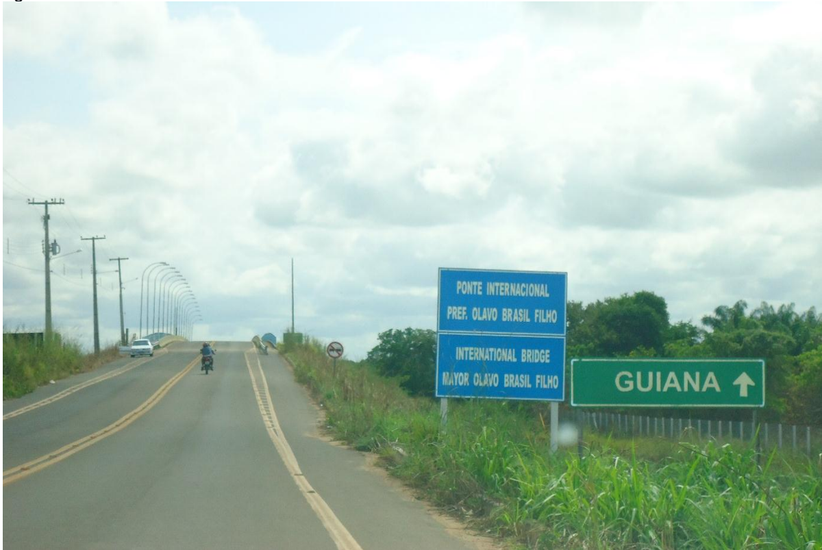
Figura 2 Ponte sobre o rio Tacutu
