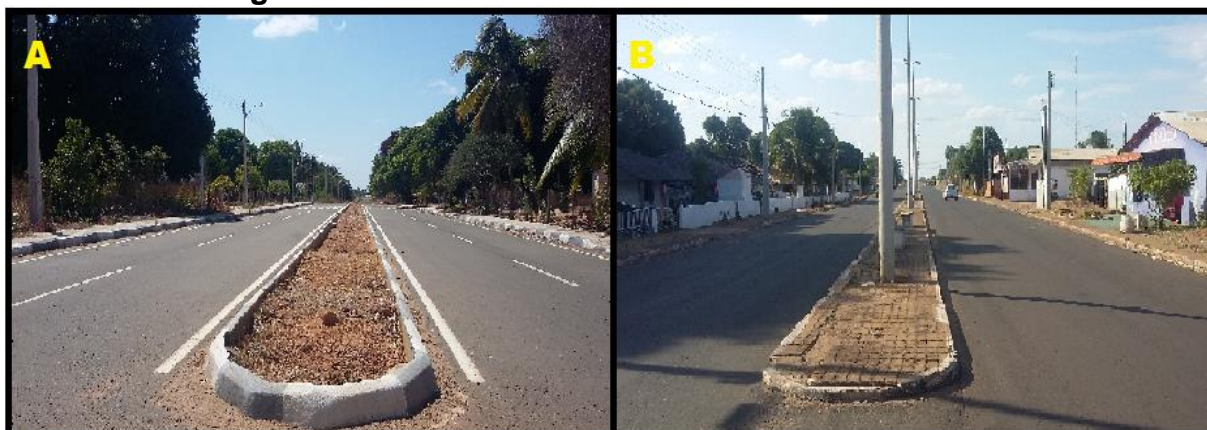
Figura 6 - Infraestrutura dos Bairros de Bonfim - RR
