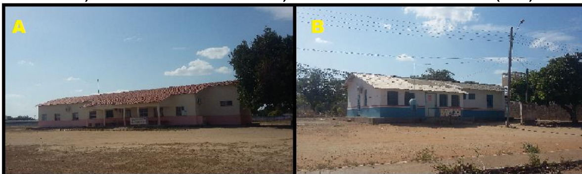
Figura 9 - Infraestrutura Municipal de Saúde de Bonfim A) Posto de Saúde - 9 de Julho B) Posto de Saúde - São Francisco (2016)
