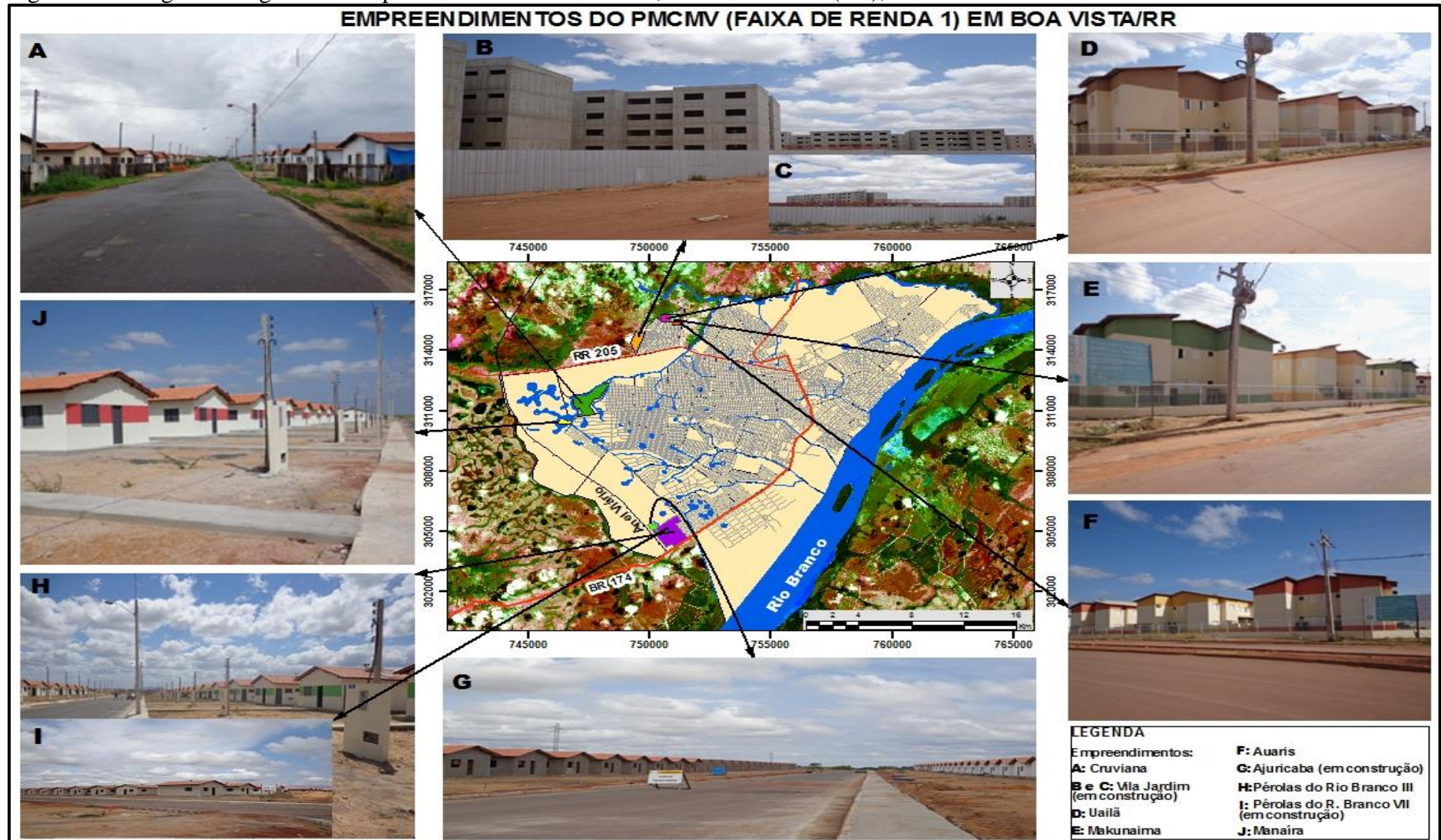
Figura 23 - Imagens de alguns dos empreendimentos do PMCMV, faixa de renda 1 (um), na cidade de Boa Vista/RR
