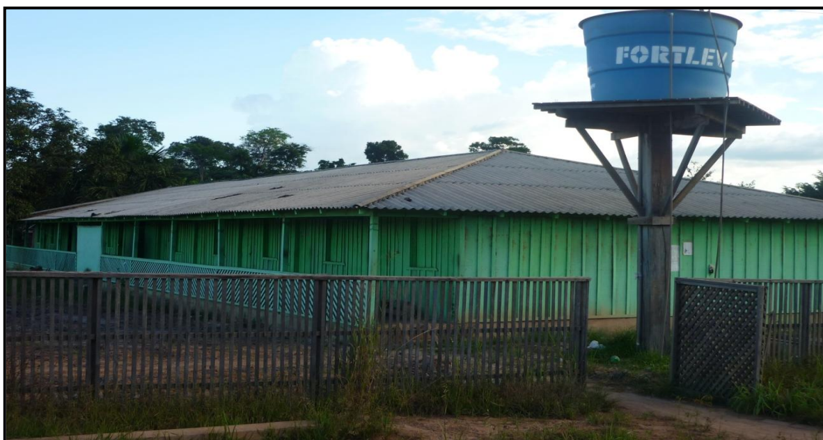
Figura 19 – Modelo habitacional construído pelas empresas madeireiras para trabalhadores solteiros
