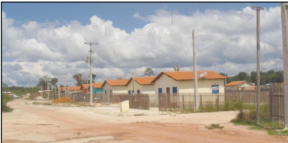
Figura 18- Processo de ocupação e uso do solo “urbano” do Aglomerado de Nova Colina em 2012 – conjunto habitacional
