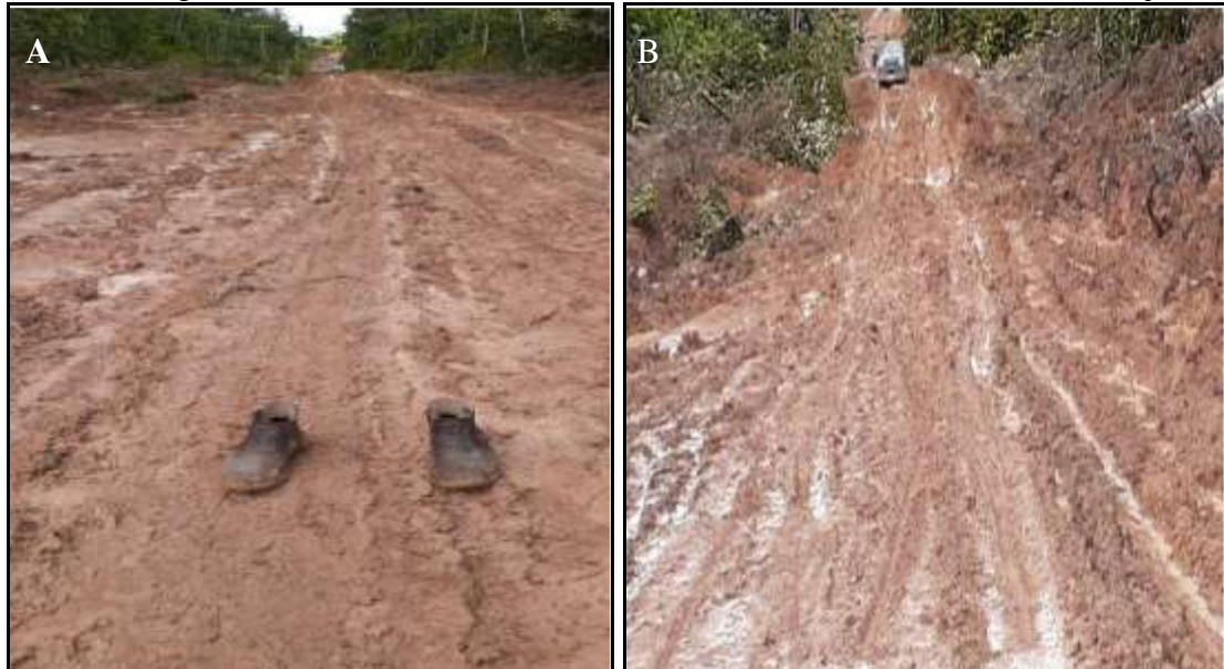
Figura 17 - Infraestrutura das estradas vicinais no assentamento Sucuriju
