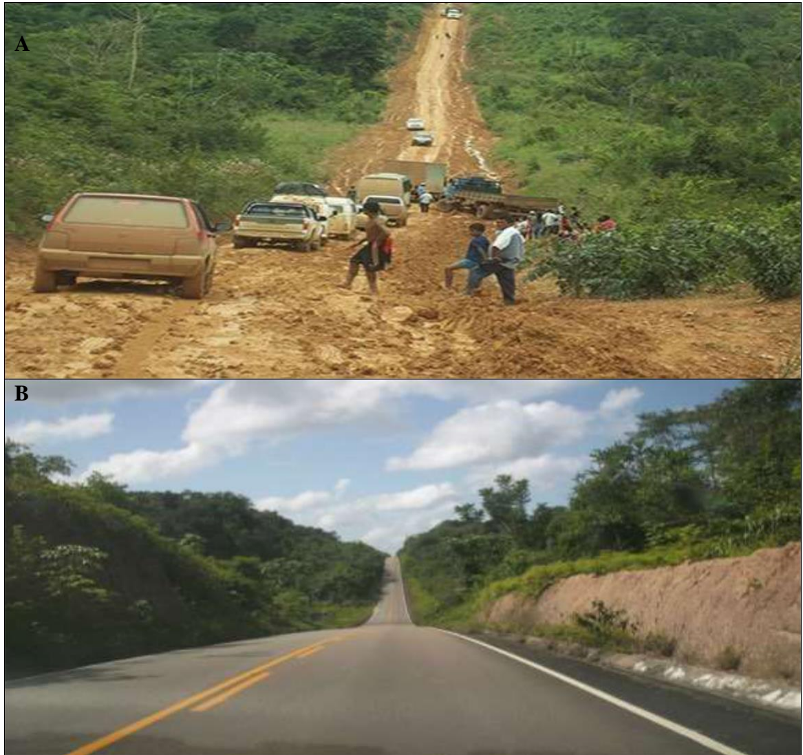
Figura 2 - Processo de construção e pavimentação da BR-174
