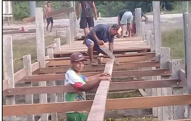
Figura 17 - Construção da ponte no Setor III
