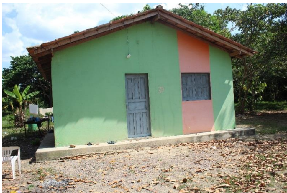
Figura 63 - Casa do conjunto habitacional.
