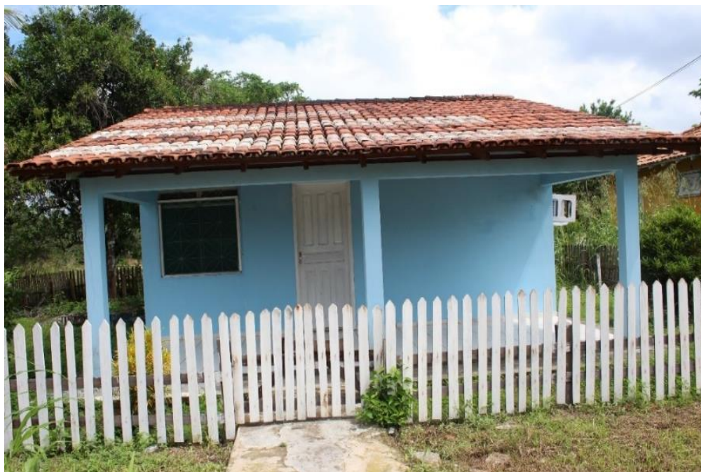
Figura 31 - Casa de apoio dos médicos na comunidade.
