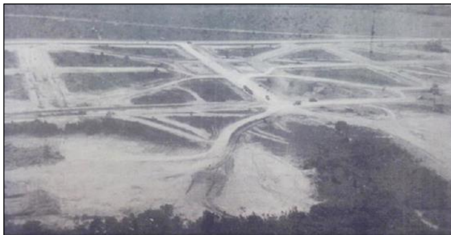
Figura 13 – Vista aérea do projeto executado em 1974 dos módulos oitavados.
