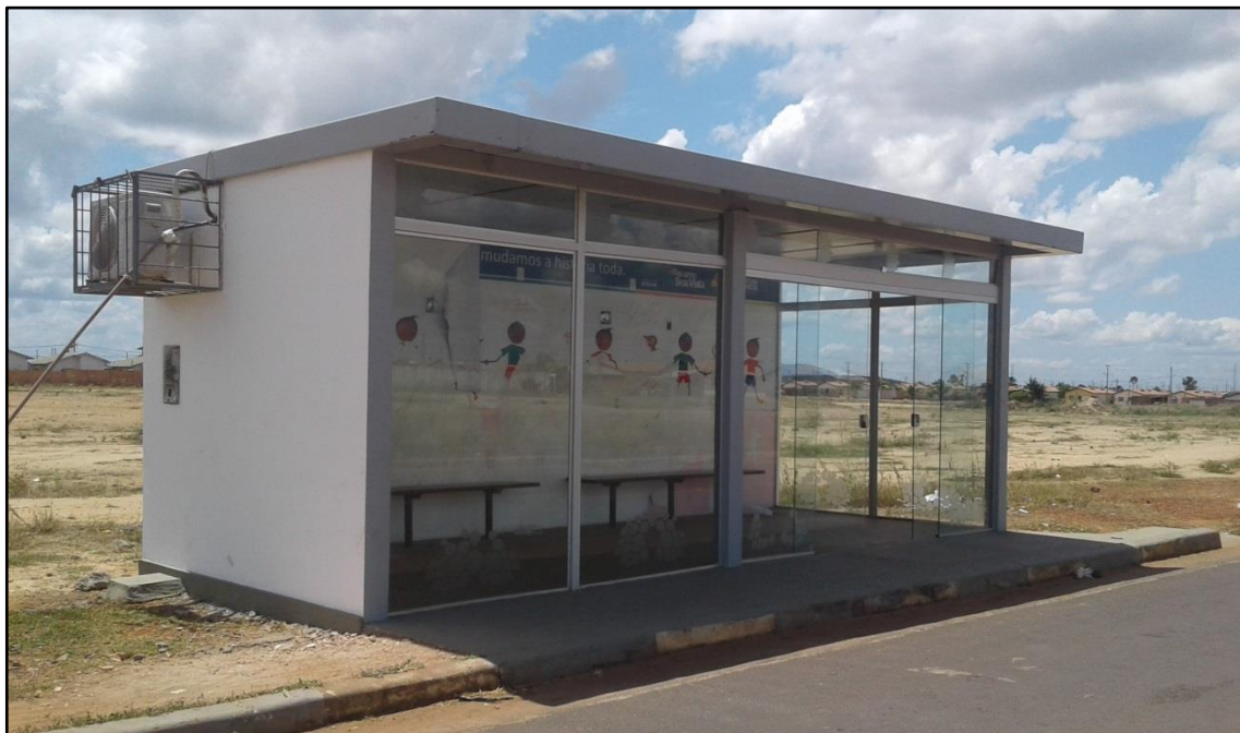
Figura 11. Parada climatizada em Boa Vista/RR – 2017
