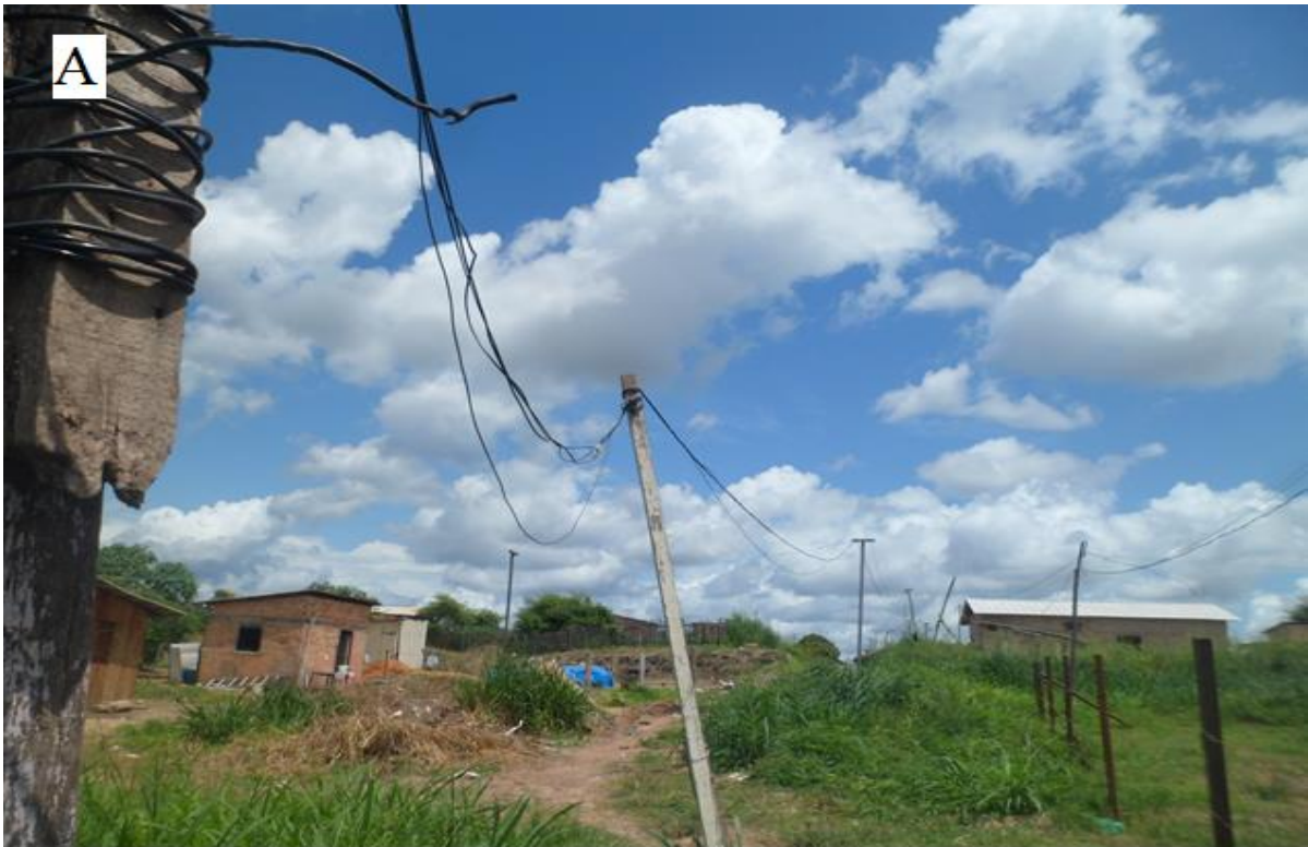
Figura 17: (A) e (B) Imagens com postes e fios condutores de eletricidade improvisados no assentamento.
