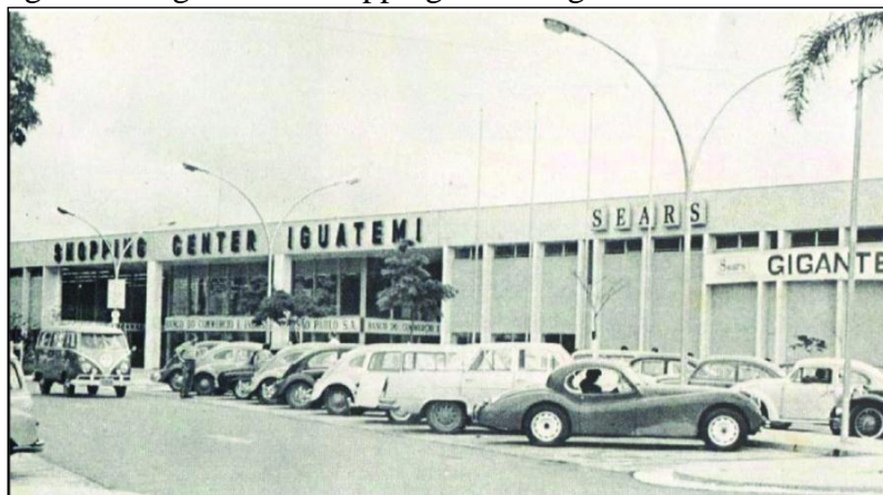
Figura 9: Registro do Shopping Center Iguatemi de 1967
