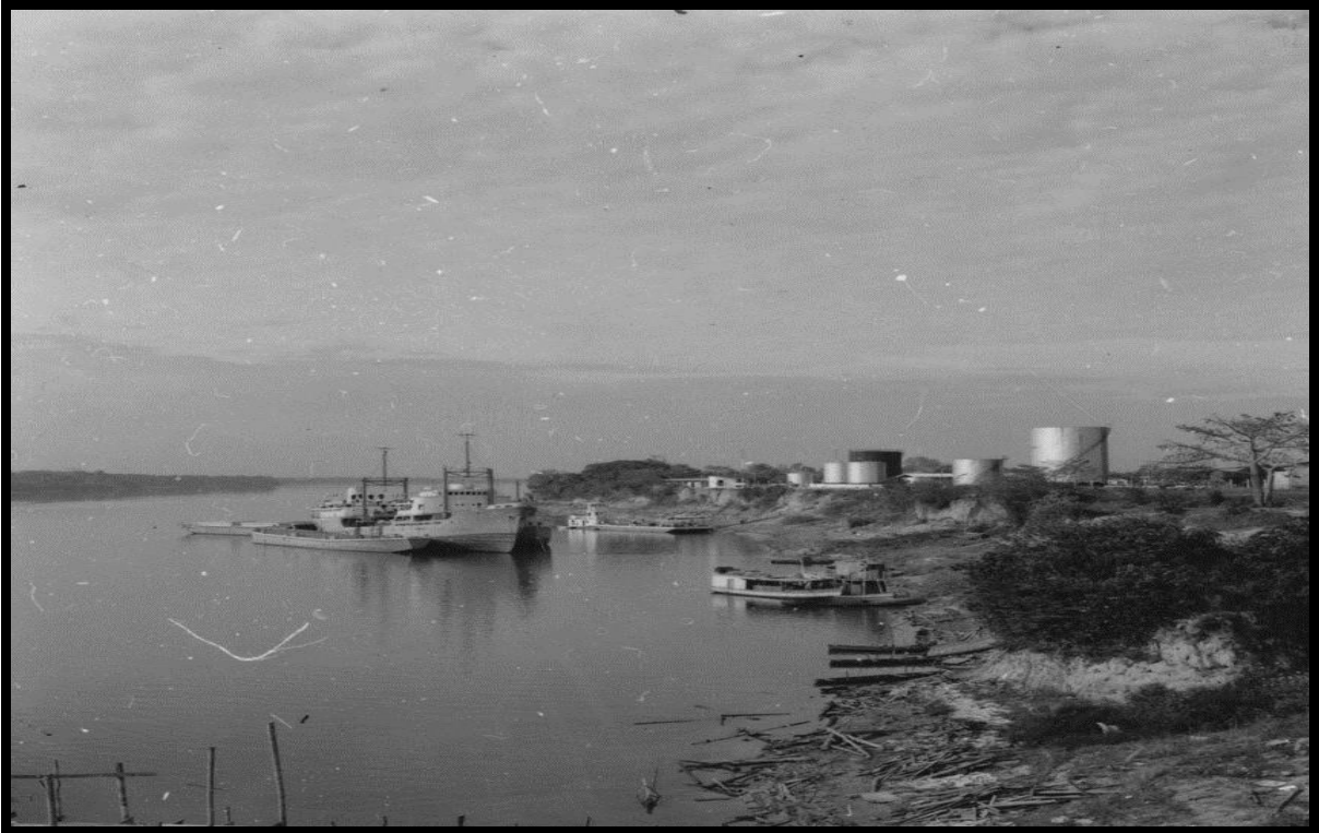
Figura 04 - Vista do Rio Branco, tomada do cais em construção de Caracaraí (RR) para justante em 1978.
