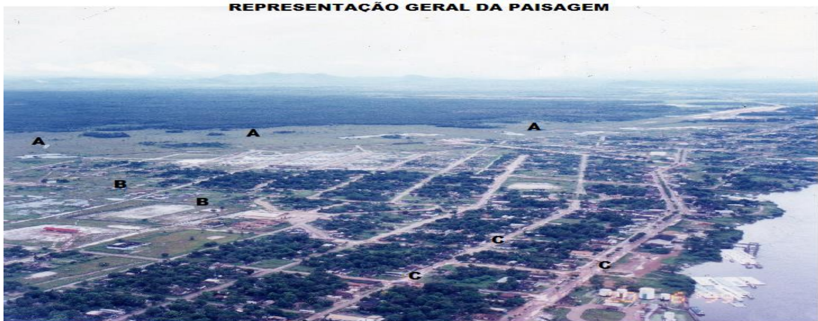
Figura 14 – Aspectos identificados na paisagem no perímetro urbano da cidade de Caracará (RR) na década 90.
