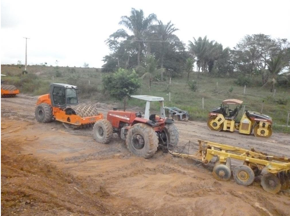
Figura 03 – Fotografia 02– Recuperação de estradas no Município do Cantá
