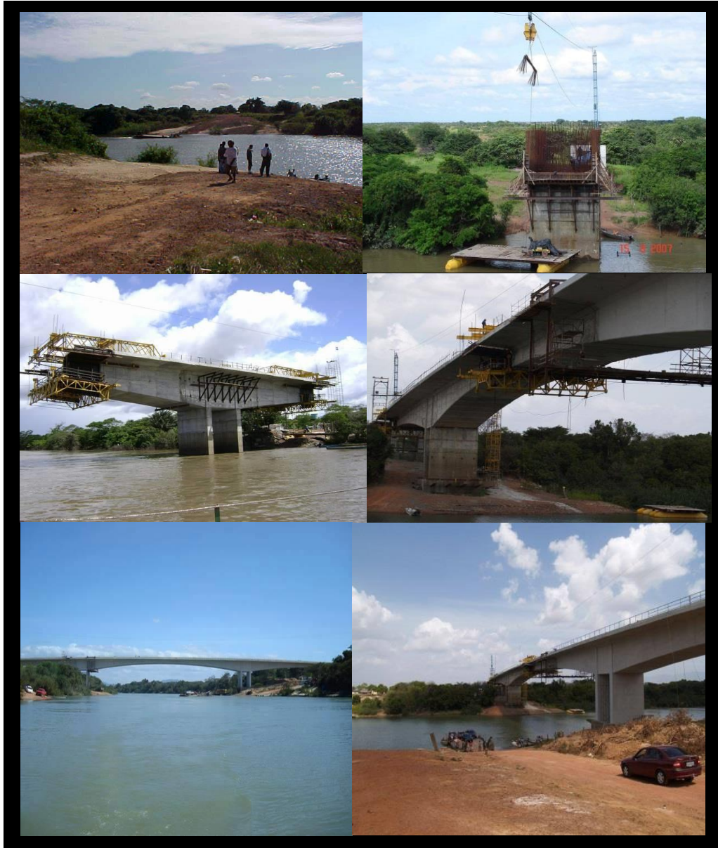
Figura 5: Composição das fases de construção da ponte sobre o Rio Tacutu, Fronteira Brasil-Guiana
