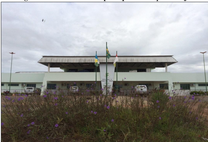
Figura 4 - Vista da entrada principal do Campus Amajari
