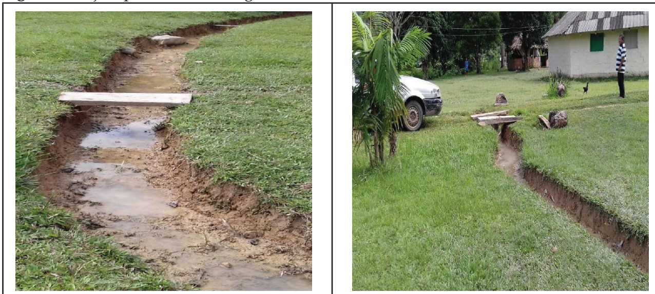
Figura 4: Sarjeta para coleta de esgoto na comunidade
