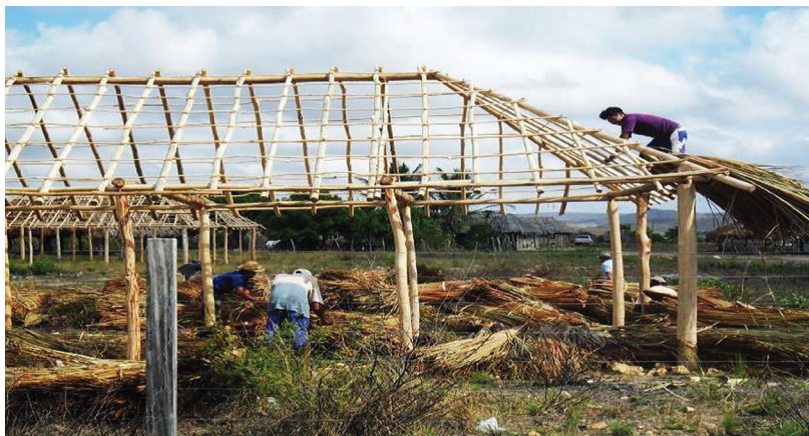
Figura 02. Construção de casa na comunidade.
